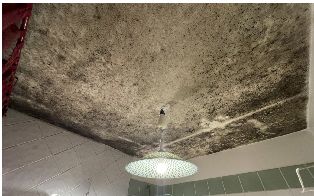
Résidence Balbaia (HSA, Ciboure), construite en 2007
